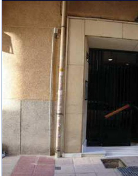
Se utilizará tubo de PVC no propagador de llama para proteger las tiradas principales entre la batería de contadores y el lugar de instalación del equipo BUS-VHF. Este tubo de PVC solamente se podrá usar en instalaciones interiores, ya que para instalaciones exteriores se usará siempre tubo de acero. En las tiradas de tubo se instalarán cajas de registro cada 15 metros como mínimo. Dentro de estas cajas de registro no existirá ningún empalme, pasando el cable a través de ellas.
