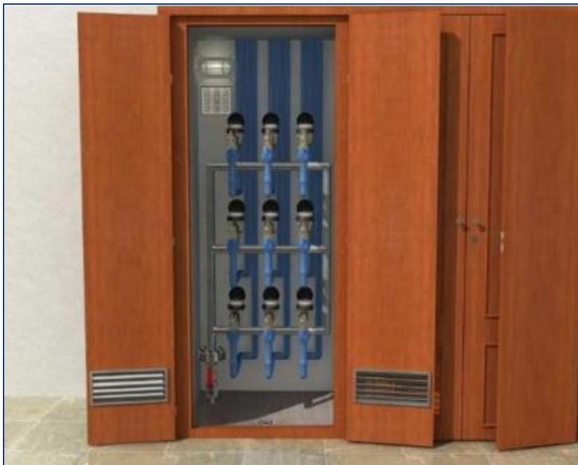
El armario o cuarto de batería deberá quedar en PLANTA BAJA, en lugar de fácil acceso y de uso común en el inmueble.
