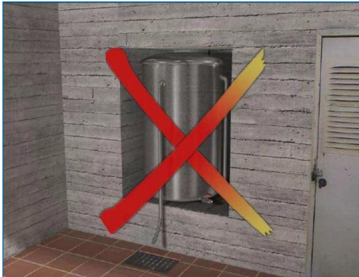
El tubo de alimentación verterá libremente y como mínimo 40 mm por encima del borde superior del rebosadero.
