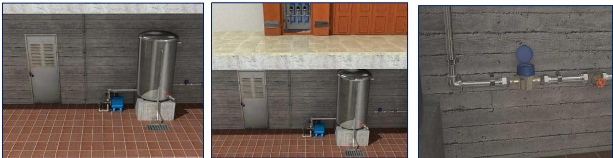
En el croquis nº 4.6.7. se detallan todos los elementos necesarios en la instalación de depósitos de reserva y alimentación a grupos convencionales de elevación.
