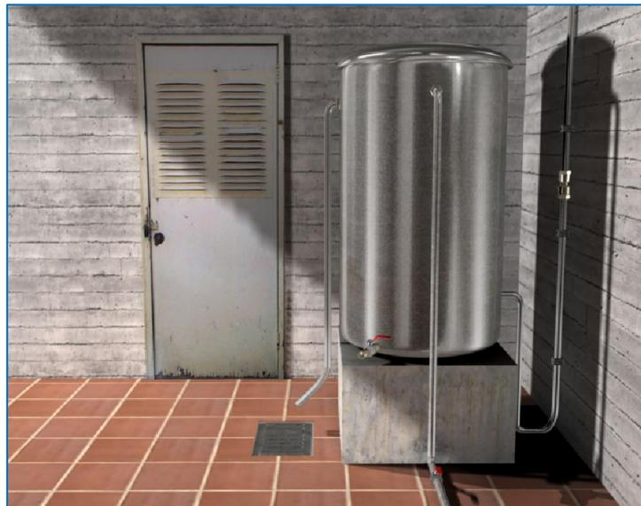
El orificio de salida estará, como mínimo, a 50 mm por encima del fondo del depósito.
