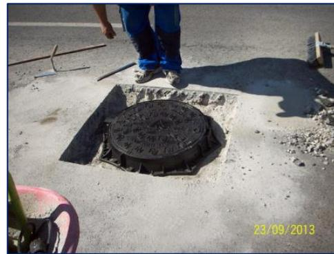
Para el caso de instalación de registros en nuevos pozos, se procederá de manera similar, comprobando el correcto estado de la parte superior del pozo donde irá apoyado el registro. En caso de existencia de partes desprendidas o deterioradas, éstas se deberán restaurar, comprobando que la superficie queda limpia de restos de polvo o grasa.
