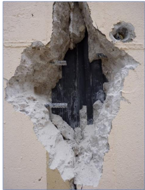
Imagen 137 Detalle de fisura transversal en depósito de agua potable: ausencia de continuidad de armadura, aunque presencia de junta wáter stop
