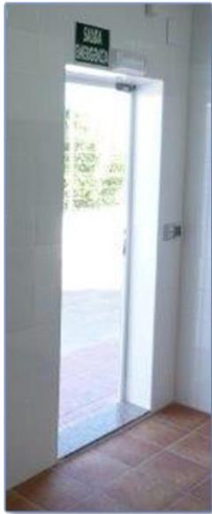
Imagen 74 Ejemplo de puerta de acceso a sala
