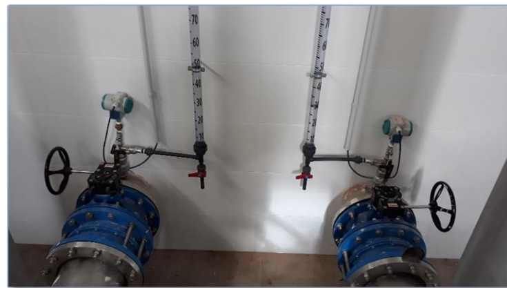
Imagen 41 Detalle visores de nivel de las cámaras
