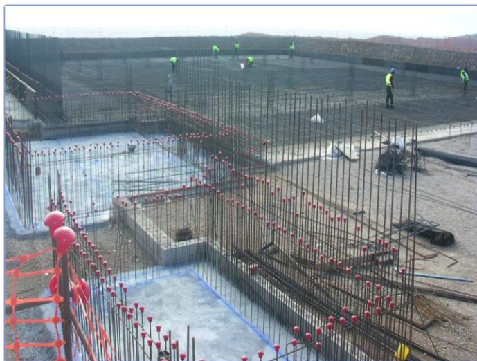
Imagen 93 Ejecución de losa de cimentación
