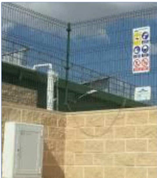
Imagen 80 Armario de toma de muestras ubicado en vallado exterior
