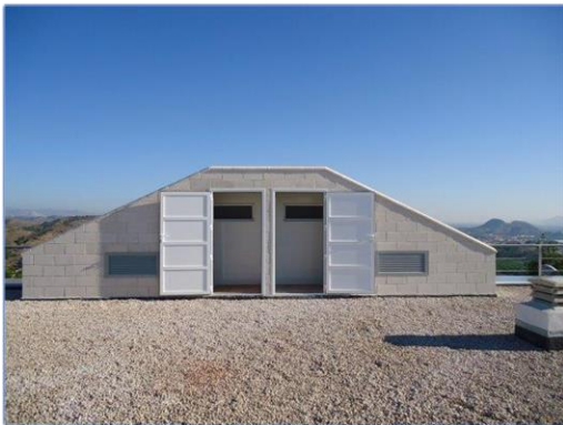
Imagen 34 Ejemplo de acceso desde cubierta
