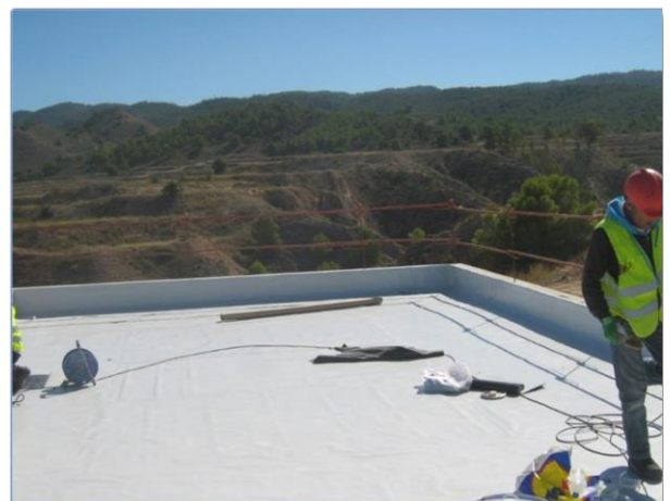
Imagen 118 Impermeabilización y aislamiento térmico de cubierta (tela asfáltica)
