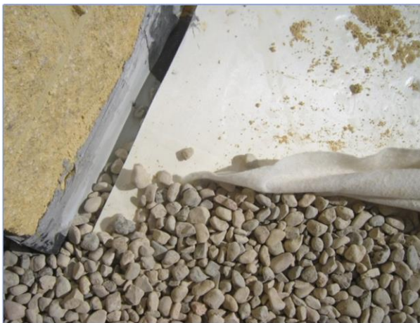
Imagen 121 Impermeabilización y aislamiento térmico de cubierta (geotextil y grava sobre porexpan)
