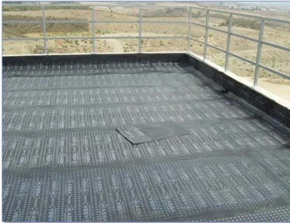
Imagen 119 Impermeabilización y aislamiento térmico de cubierta (tela asfáltica)
