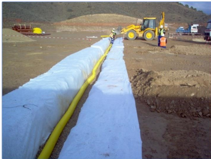
Imagen 92 Ejecución de drenaje bajo losa de cimentación
