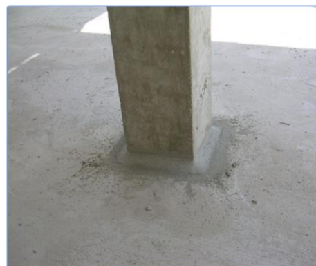
Imágenes 125 Interior del depósito: detalle de ejecución de encuentros (medias cañas) con mortero de base mineral entre elementos ortogonales
