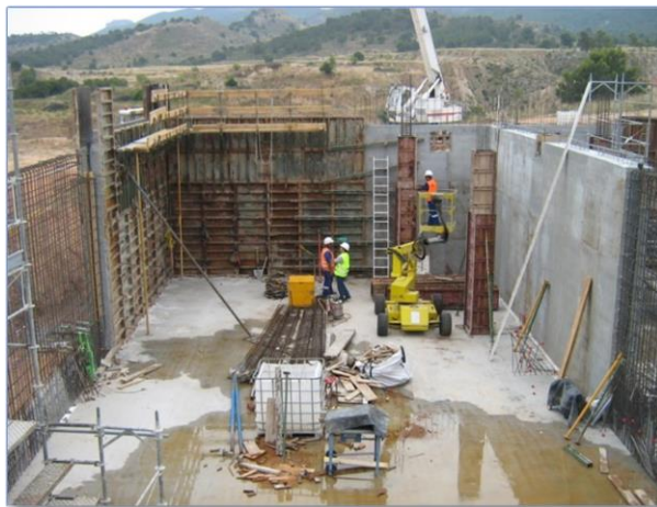
Imagen 104 Ejecución de muros por paneles (Dpto. La Ermita)
