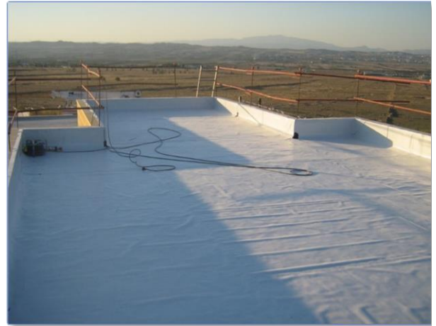
Imagen 114 Impermeabilización y aislamiento térmico de cubierta (tela asfáltica)
