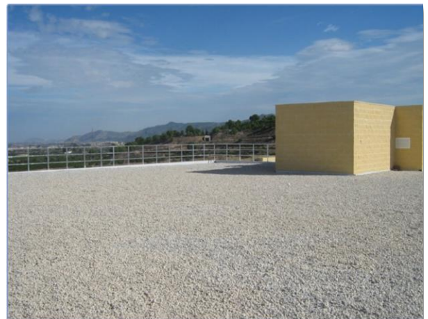
Imagen 122 Impermeabilización y aislamiento térmico de cubierta (terminación)
