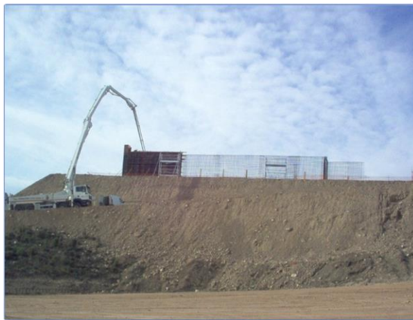
Imagen 100 Ejecución de muros por paneles (Dpto. Nueva Condomina)
