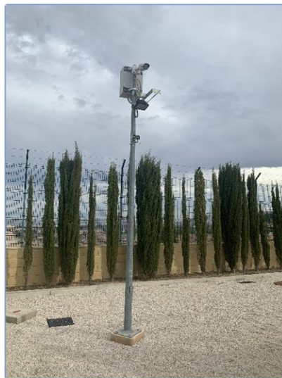
Imagen 86 Ejemplo de vallado y seto perimetral, así como distancia entre seto y circuito de vigilancia
