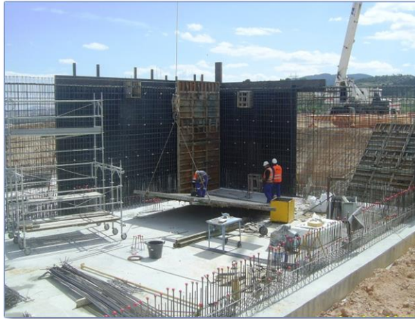
Imagen 102 Ejecución de muros por paneles (Dpto. La Ermita)
