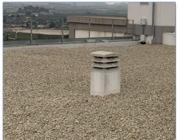
Imagen 72 Ejemplos de ventilación mediante chimeneas en cubierta
