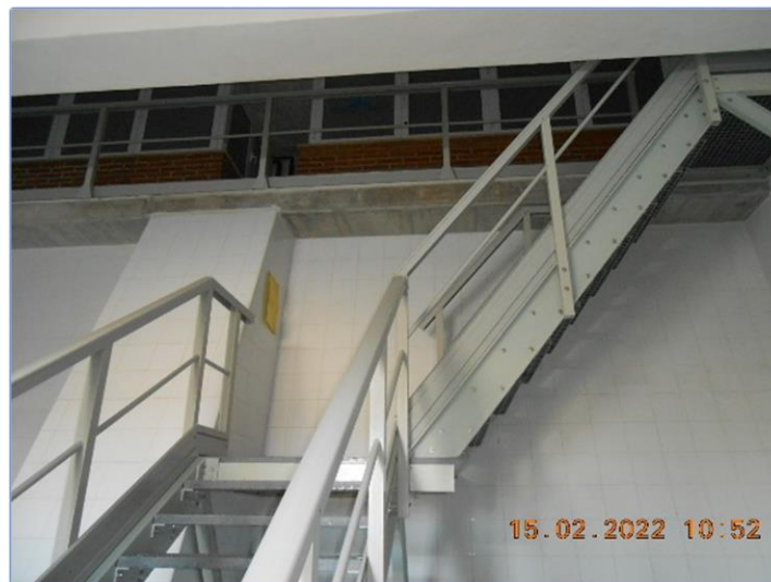
Imagen 46 Ejemplo de acceso a zona de acceso a vasos desde sala de válvulas de salida ejecutado en PRFV
