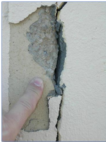
Imágenes 138 Otros ejemplos de fisura transversal en depósito de agua potable
