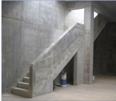
Imagen 37 Ejemplo de acceso a cámara mediante escalera de hormigón.
