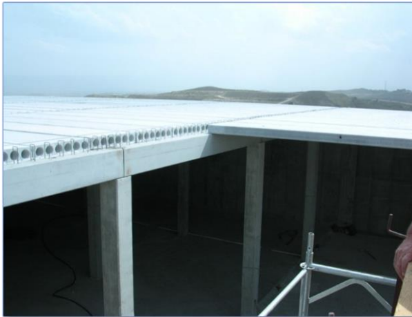
Imagen 111 Ejecución de cubierta con placas alveolares
