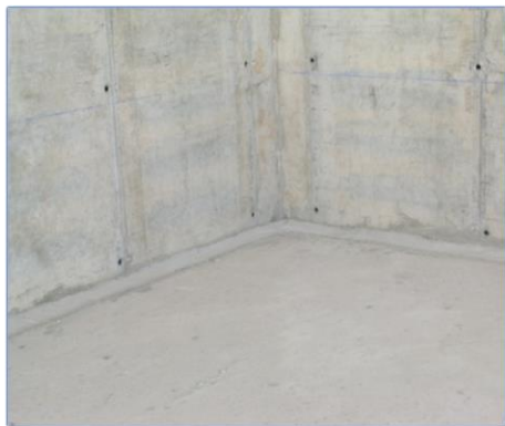
Imágenes 125 Interior del depósito: detalle de ejecución de encuentros (medias cañas) con mortero de base mineral entre elementos ortogonales
