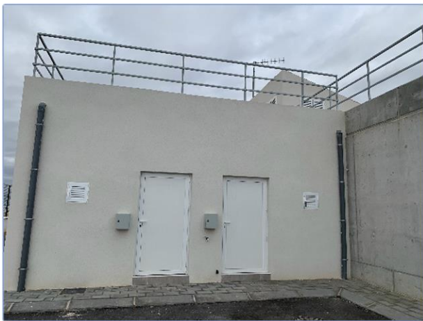
Imagen 62 Ejemplo de bajantes y barandilla en cubierta de salas.
