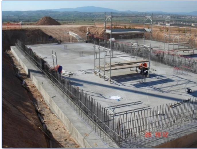
Imagen 97 Ejecución de losa de cimentación
