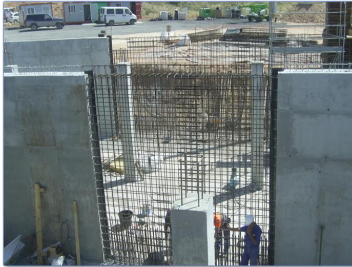
Imagen 106 Ejecución de muros por paneles (Dpto. La Ermita)
