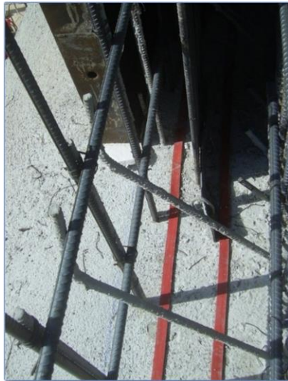
Imagen 107 Ejecución de juntas muro-losa (water-stop e hidrófila doble en muro divisorio)
