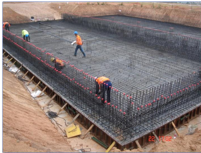
Imagen 95 Ejecución de losa de cimentación
