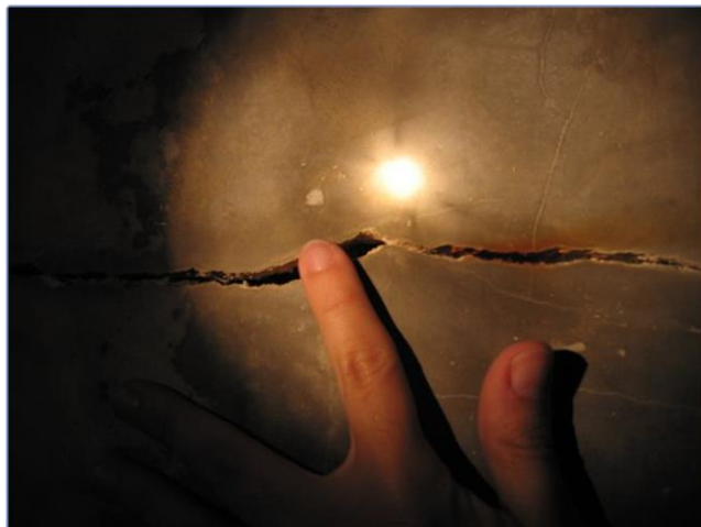
Imágenes 138 Otros ejemplos de fisura transversal en depósito de agua potable
