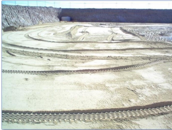
Imagen 91 Excavación en talud y base de arena para apoyo de losa de cimentación
