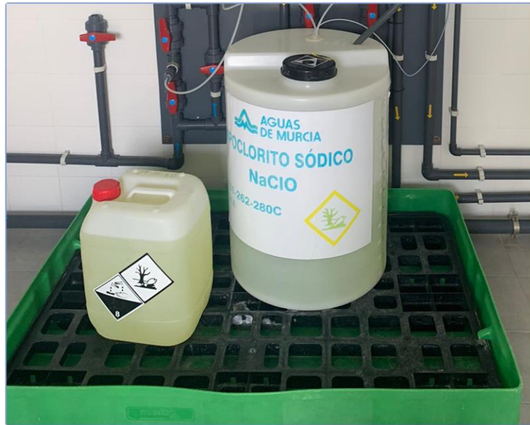
Imagen 55 Ejemplo de etiquetado y colocación de recipiente de hipoclorito sobre cubeto
