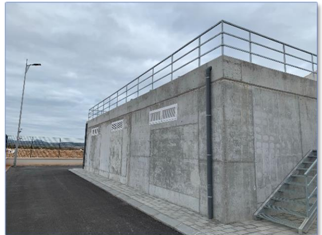
Imagen 63 Ejemplo de bajantes y barandilla en cubierta de cámaras
