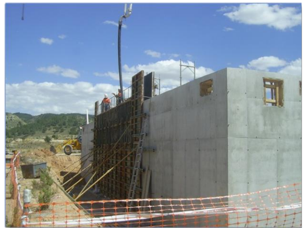
Imagen 105 Ejecución de muros por paneles (Dpto. La Ermita)
