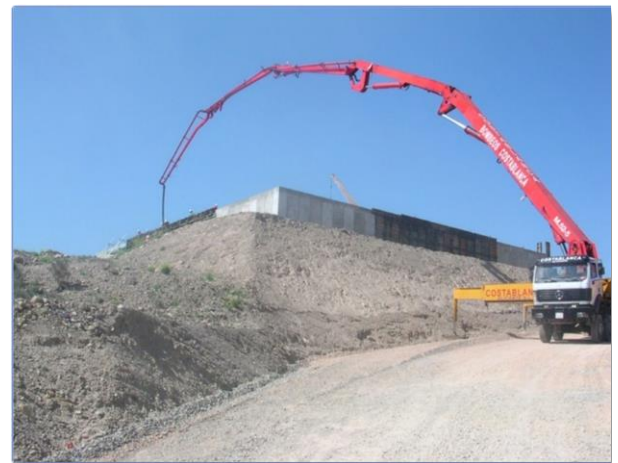
Imagen 101 Ejecución de muros por paneles (Dpto. Nueva Condomina)
