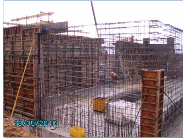
Imagen 103 Ejecución de muros por paneles (Dpto. La Ermita)
