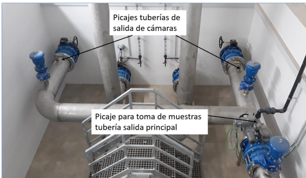
Imagen 18 Ejemplo de picajes en instalación existente
