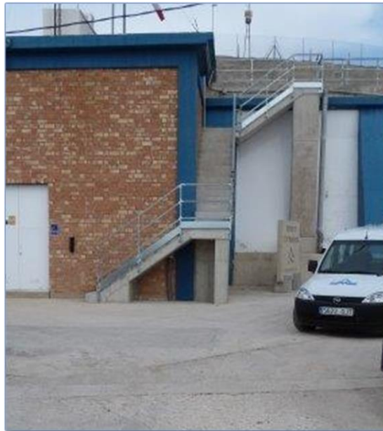
Imagen 68 Ejemplo de escalera de acceso a cubierta
