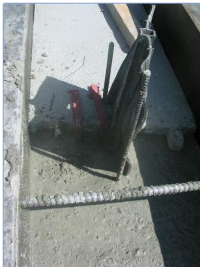
Imagen 110 Ejecución de juntas entre paneles verticales (water-stop e hidrófila doble)
