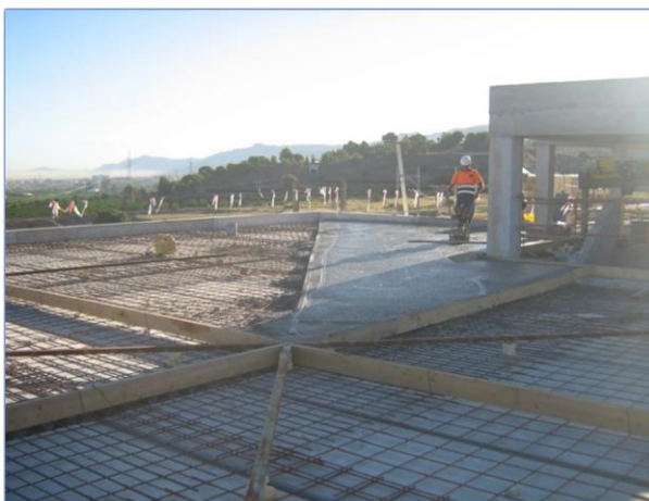
Imagen 117 Ejecución de cubierta (limahoyas y limatesas)
