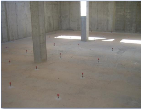
Imagen 123 Interior del vaso: replanteo para ejecución de pendientes
