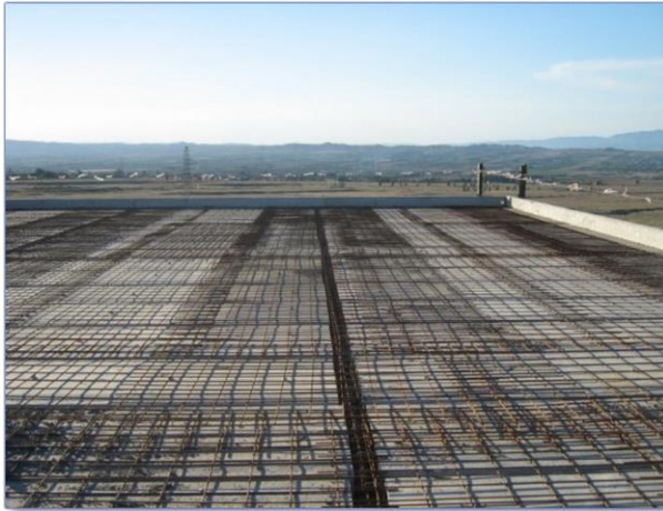
Imagen 113 Ejecución de cubierta (armado de negativos)
