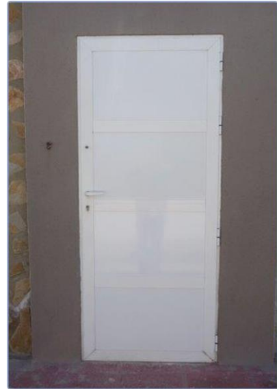
Imagen 75 Ejemplo de puerta acceso a sala vista desde el exterior
