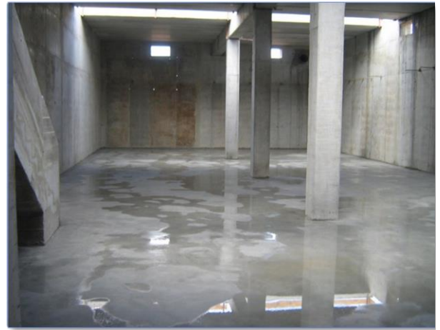
Imagen 124 Interior del depósito: ejecución de pendientes y curado del hormigón
