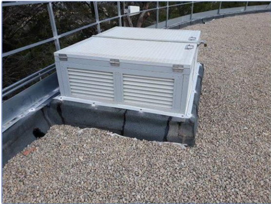
Imagen 70 Ejemplo de tapas elevadas en huecos en cubierta
