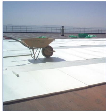
Imagen 116 Impermeabilización y aislamiento térmico de cubierta (porexpan)
