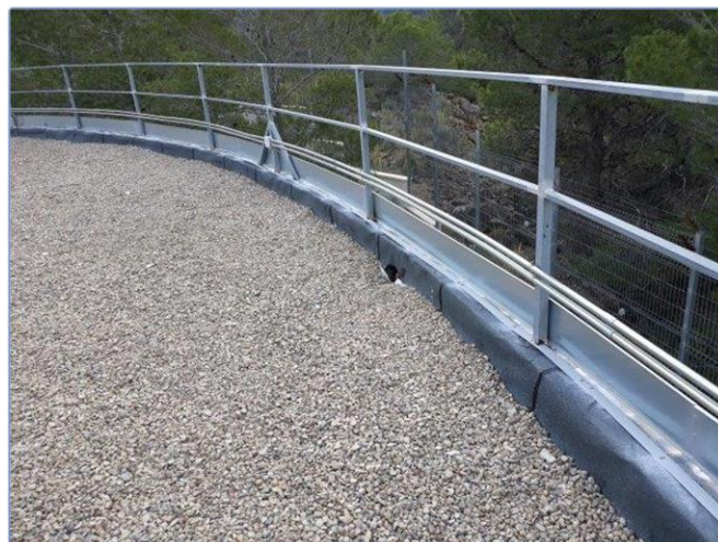
Imagen 64 Ejemplo de barandilla visto desde la cubierta
