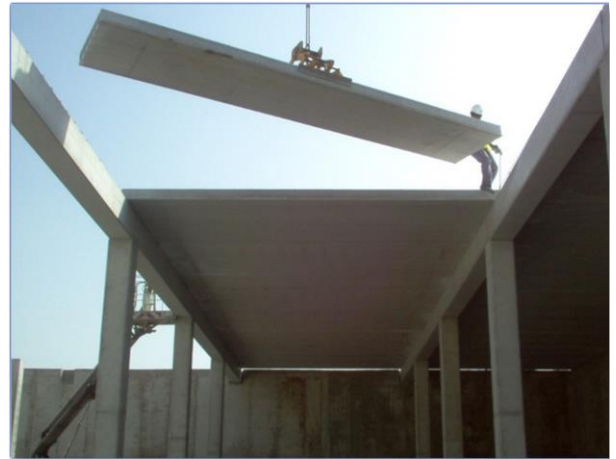
Imagen 112 Ejecución de cubierta con placas alveolares
