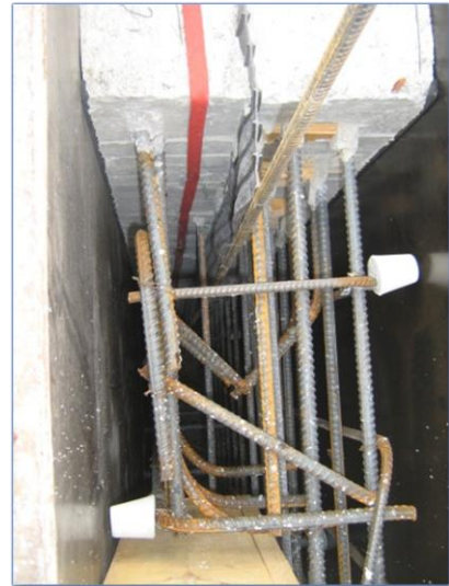
Imagen 108 Ejecución de juntas entre paneles verticales perimetrales (water-stop e hidrófila hacia el paramento exterior)
